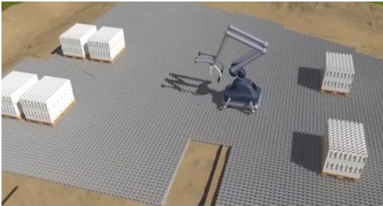
اجرای پی ساختمان با آجرهای هوشمند
