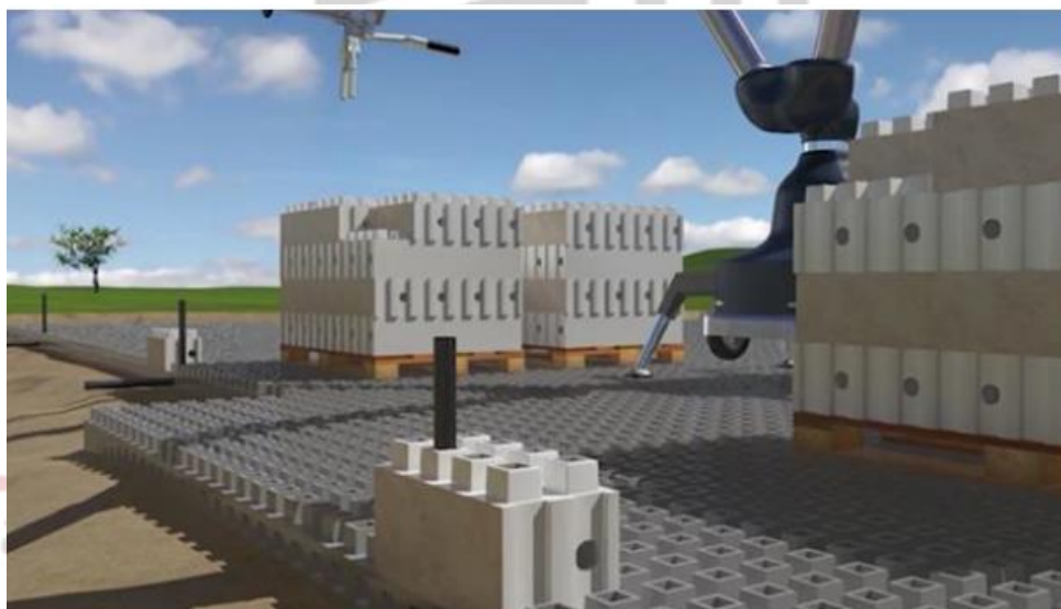
عبور لوله های تاسیساتی به صورت افقی و عمودی از پی ساختمان
